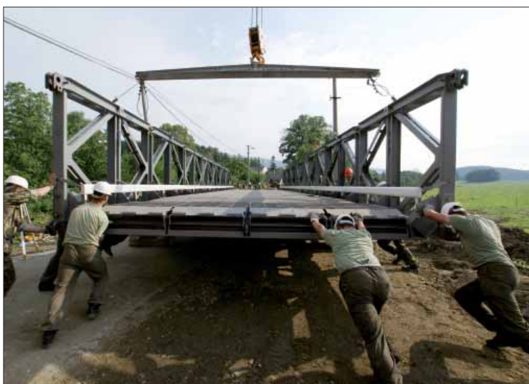
■ Stavba provizorních mostů stále patří mezi činnosti, jež ovládají vojenští ženisté. Dokázali to i v roce 2009 po povodních na Novojičínsku, odkud je tento snímek.
