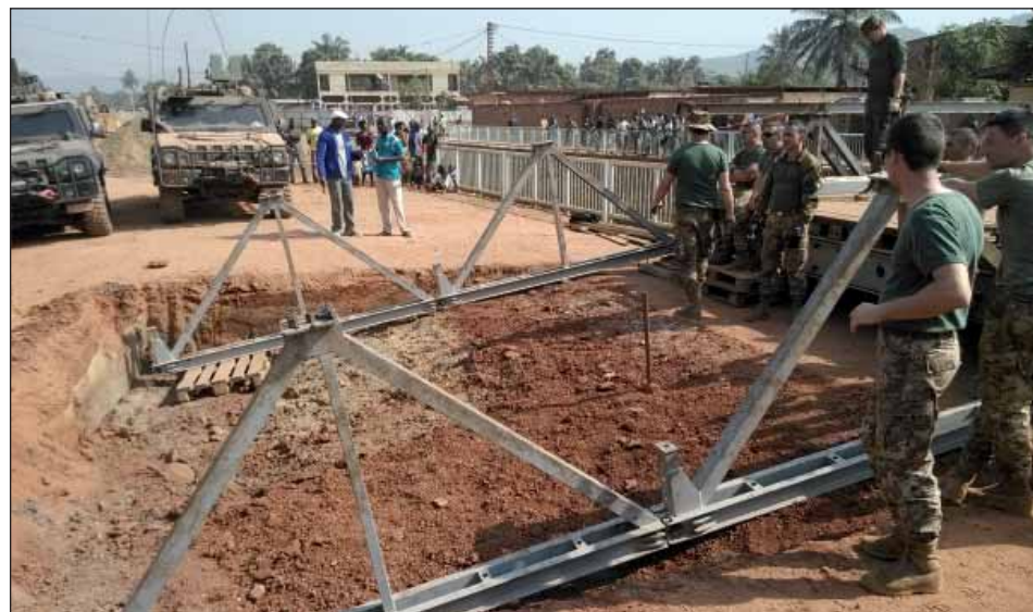
Realizace nájezdových ramp si vyžádala mnoho času
