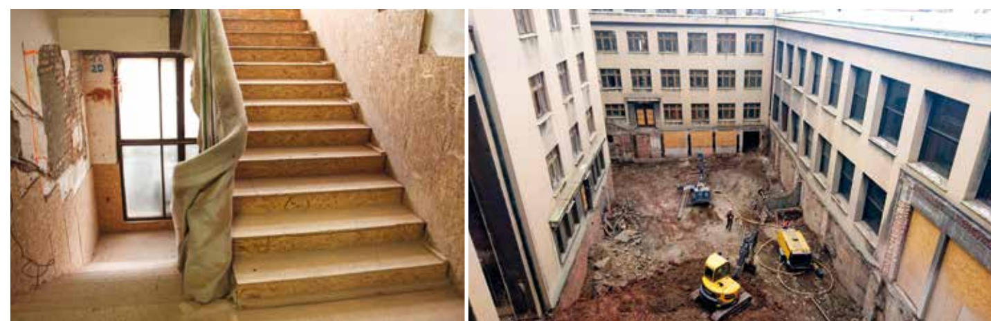
Práce ve vnitřních částech muzea, schodiště správní budovy
