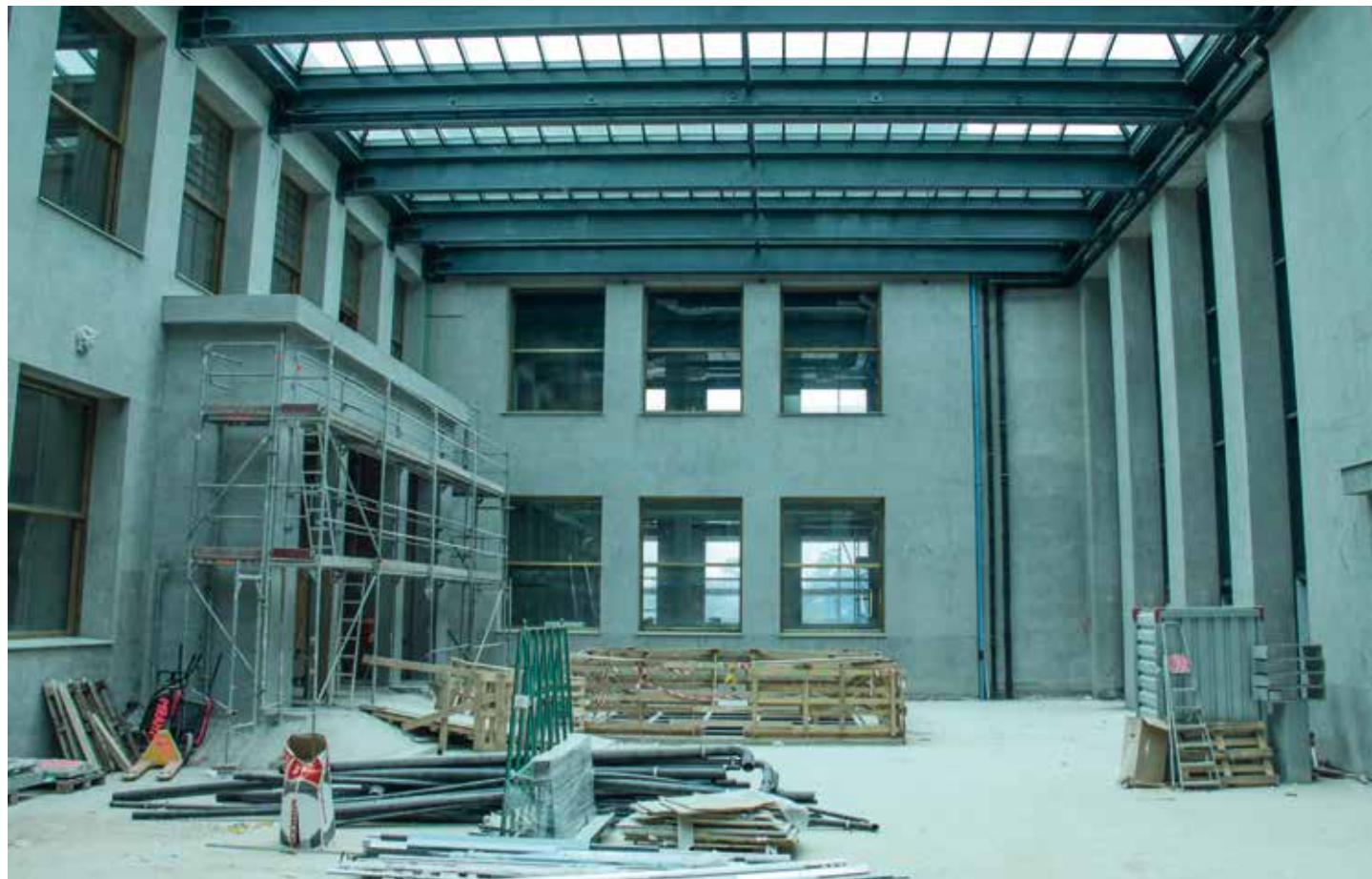
Největší vizuální změnou je zastřešení dvorany muzea. Bylo k tomu použito na 80 tun oceli.
