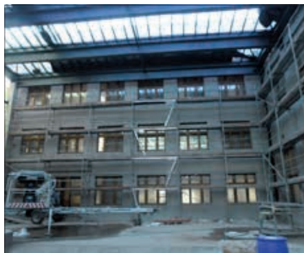
Foto probíhající rekonstrukce
