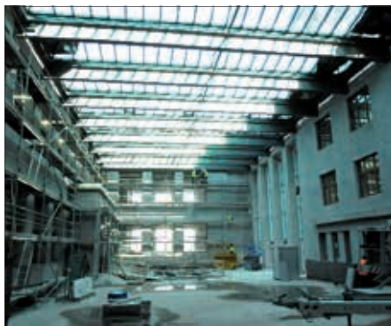
Foto probíhající rekonstrukce
