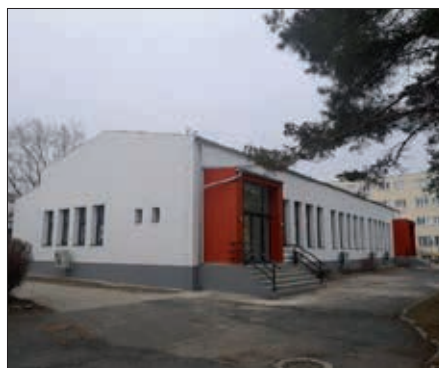
Foto po rekonstrukci
