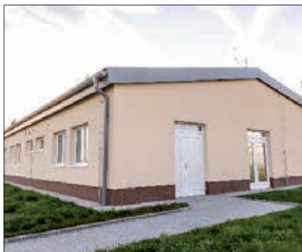
Foto po rekonstrukci
