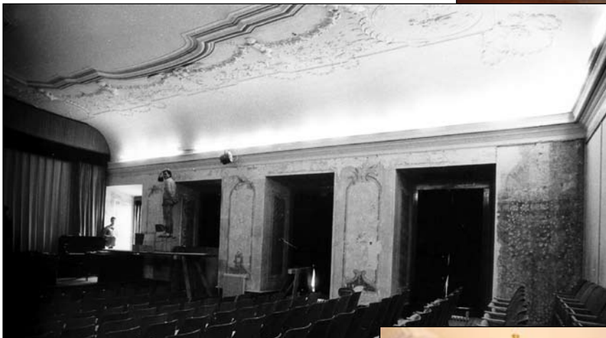
Stav Rytířského sálu těsně před rekonstrukcí
