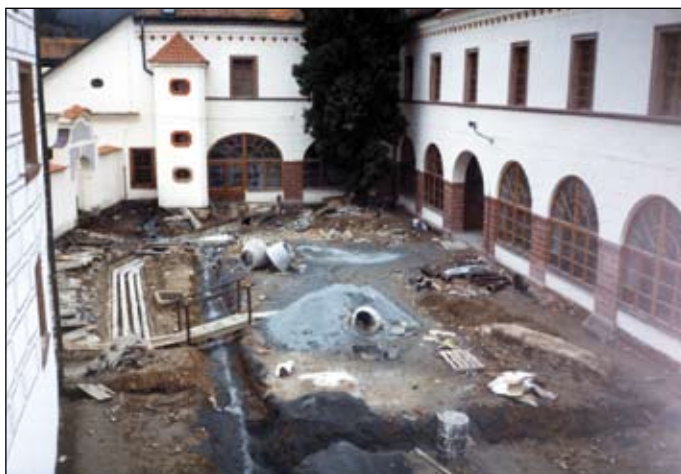
První nádvoří během rekonstrukce v roce 1997
