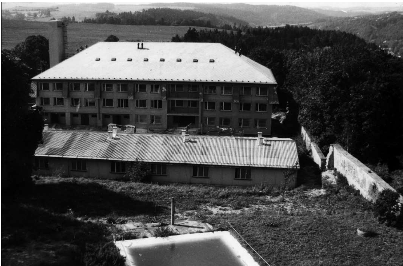
Výstavba ubytovny v roce 1987
