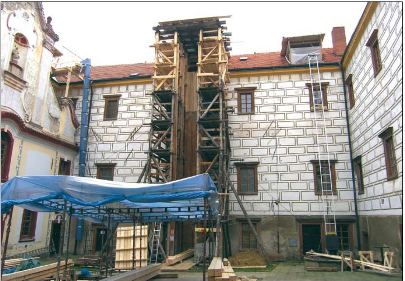
Stavební věž při rekonstrukci krovů v roce 2007
