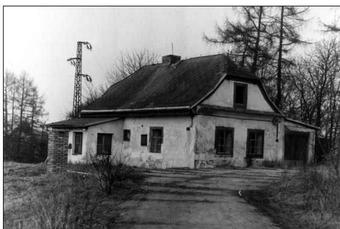
Domek sadaře před rekonstrukcí (1985)
