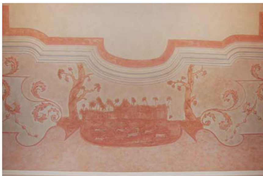
Detail stropu s loveckým výjevem
