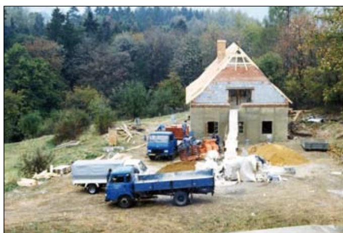
Rekonstrukce domku sadaře (1995)
