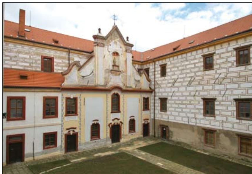
Pohled na druhé nádvoří s průčelím kaple
