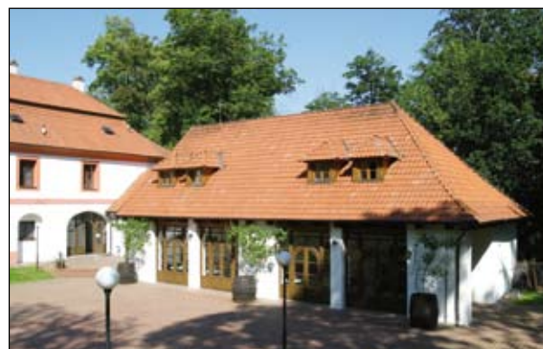
Lesovna po provedení rekonstrukce
