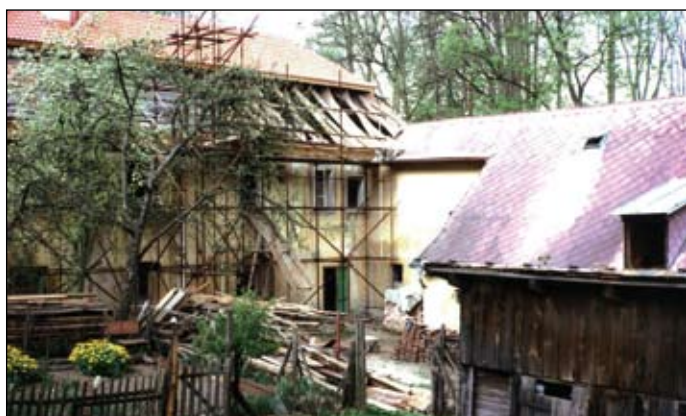
Lesovna během rekonstrukce (1992)
