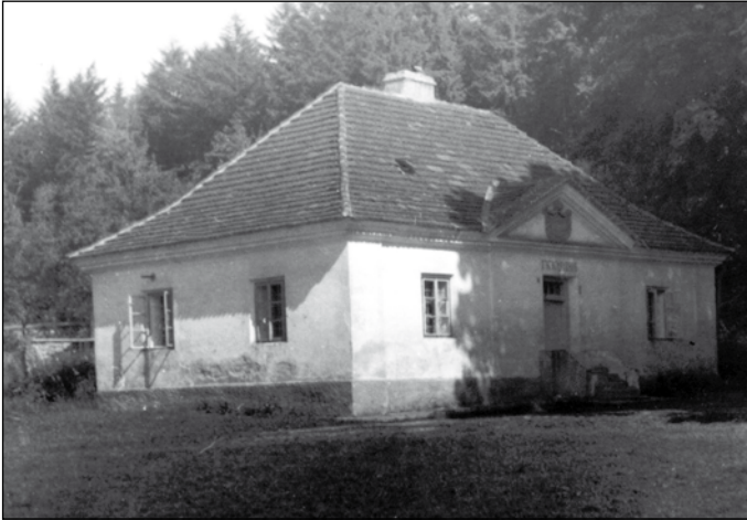
Domek zahradníka před rekonstrukcí
