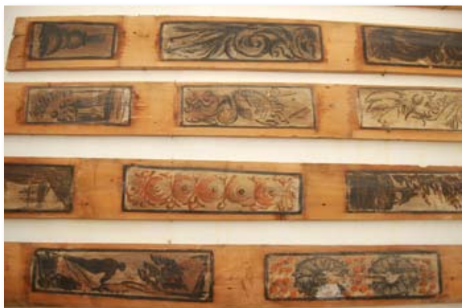
Malované desky ze stropu renesanční chodby
