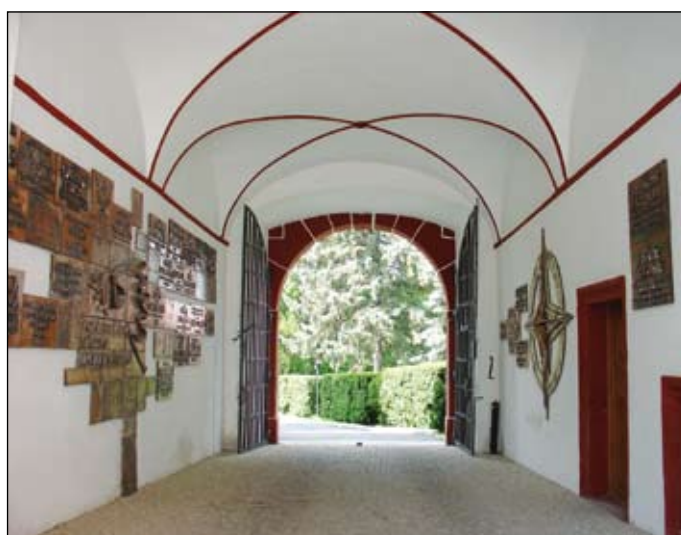
Zrekonstruovaný průchod na prvním nádvoří
