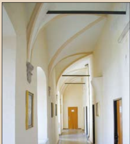
Zbytky klenby zrušeného velkého renesančního sálu
