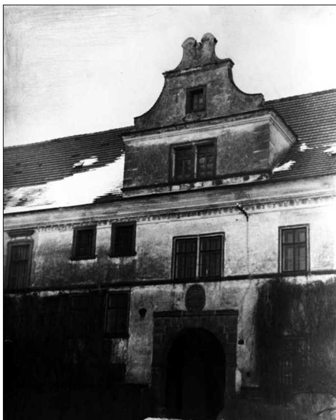
Pohled na Komorní Hrádek bez věže (1930)
