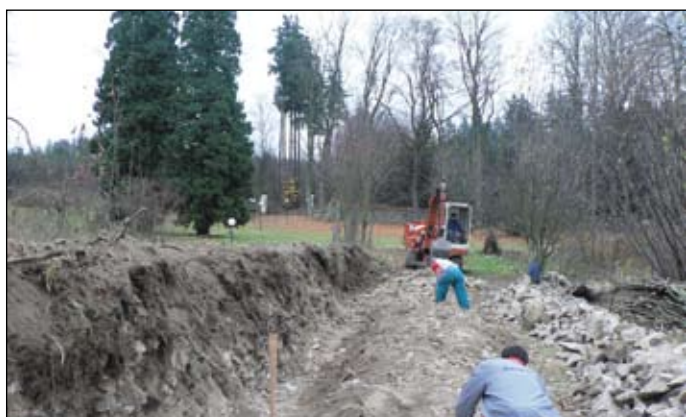
Výstavba nové opěrné zdi v roce 2005
