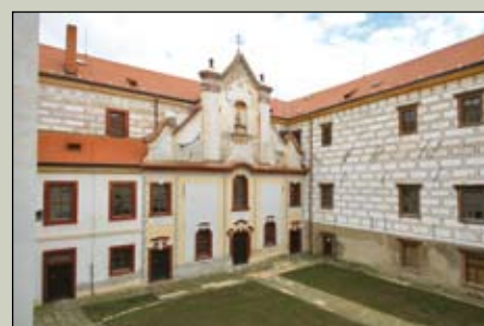
Pohled na druhé nádvoří s průčelím kaple
