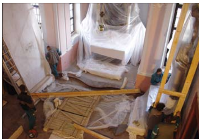
Rekonstrukce v březnu 2006
