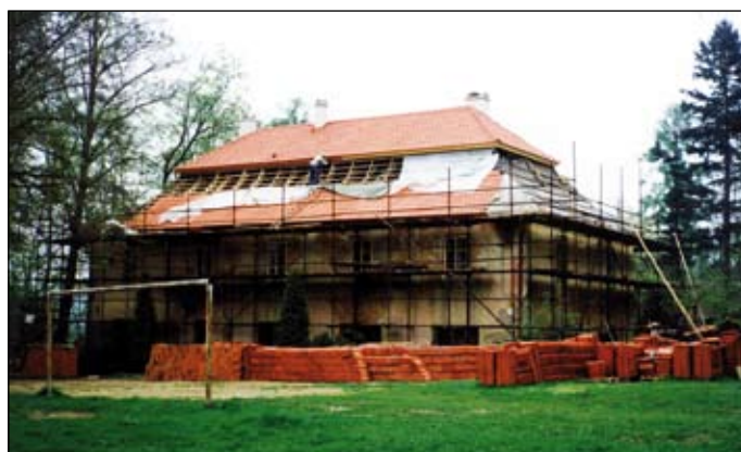
Lesovna při opravě střechy v roce 1993
