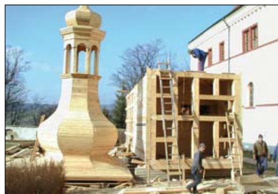
Kompletní tubus v roce 2000
