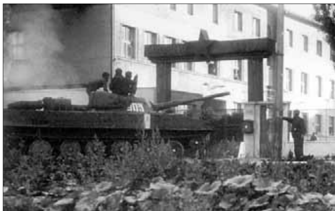
Hlaveň sovětského tanku míří na kasárna.
