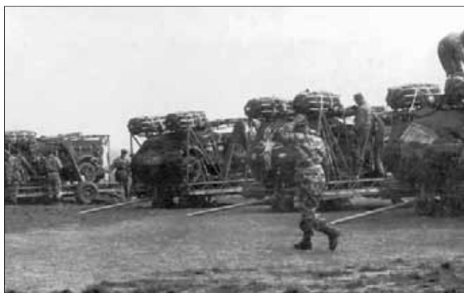
Automobily GAZ s připevněnými nákladními padáky před naložením do letounů An-12.
