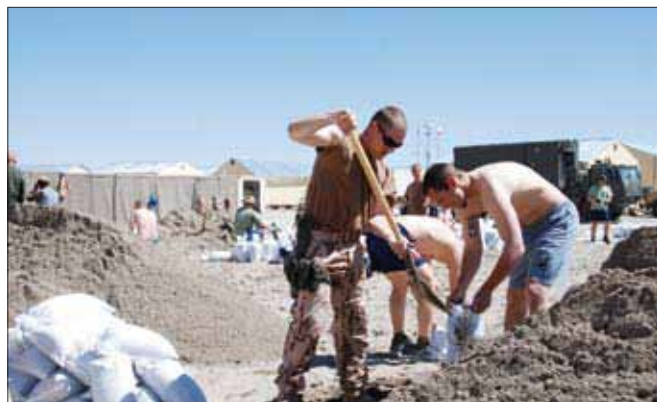
Výstavba volejbalového hřiště na základně.
