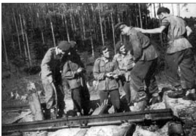
Výsadkář musel zvládnout destrukci železniční tratě.
