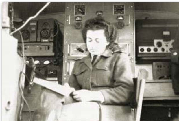
Radiotelegrafistka pojízdné letecké meteorologické stanice LPS-58, zleva radiové prostředky LR-10, PELIKÁN P-52 a Lambda 4
