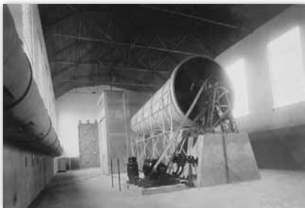
Aerodynamický tunel typu Eiffel vybudovaný v rámci VLÚS
