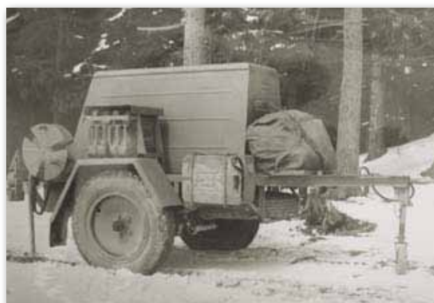
Elektrocentrála EC 7,5 kVa v soupravě LPS-65
