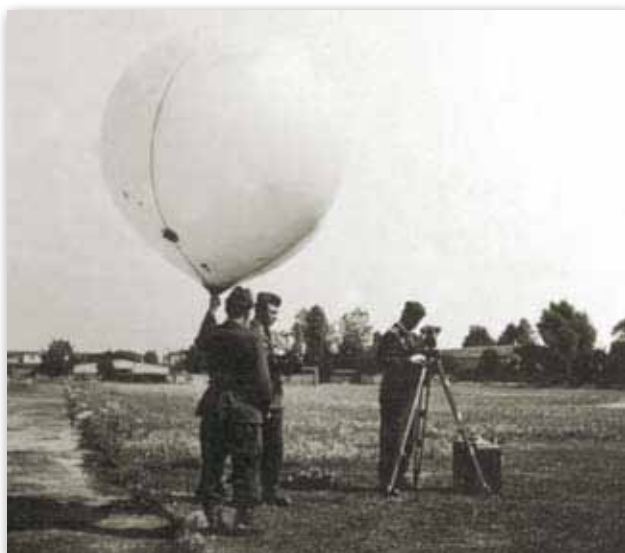
Příprava výškového měření pomocí jednopilotáže v 50. letech
