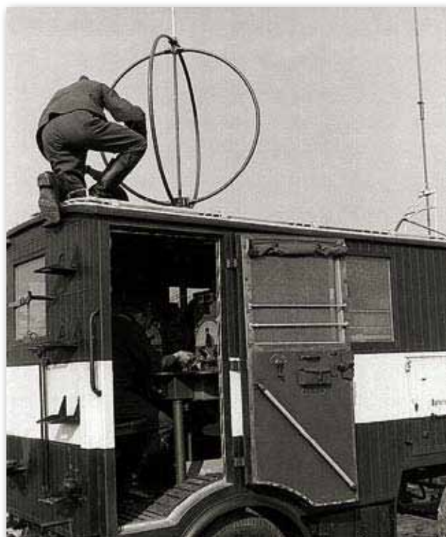
Goniometrický zaměřovač EP - 2a
