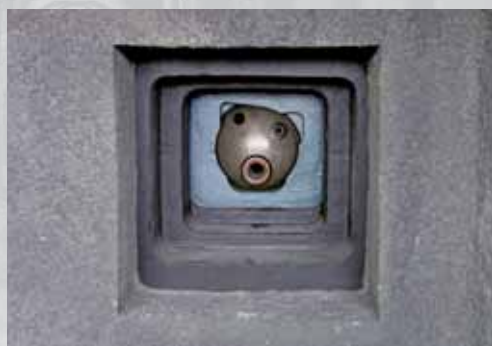
Pevnostní lafeta pro lehký kulomet vz. 26 v objektu lehkého opevnění vz. 37.
