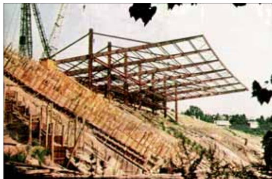
Stavba originální konstrukce zastřešení bez jediné podpěry, 25 metrů hluboké a téměř 100m dlouhé, celé zavěšené na pylonech - tak rostl stadion na Julisce.
