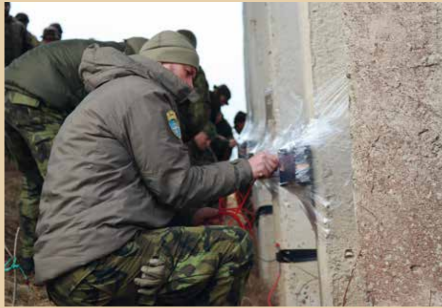
Příprava náloží na mostní pilíř ▲
